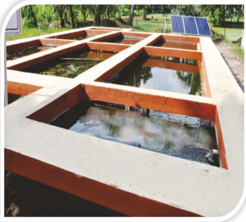
चित्र-3 : भाकृअनुप-क्रिजैफ अनुसंधान फार्म में कार्यान्वित आरसीसी टैंकों की श्रृंखला के साथ पटसन सड़न हेतु धीमी प्रवाहित जल प्रणाली
