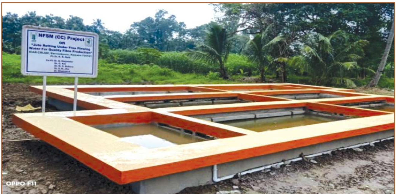
चित्र 2. धीमी गति से बहते पानी प्रणाली के साथ निर्मित आरसीसी सड़न टैंक
