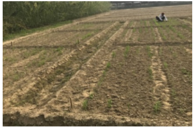
सिंचाई और जल निकासी के लिए चैनल का निर्माण
